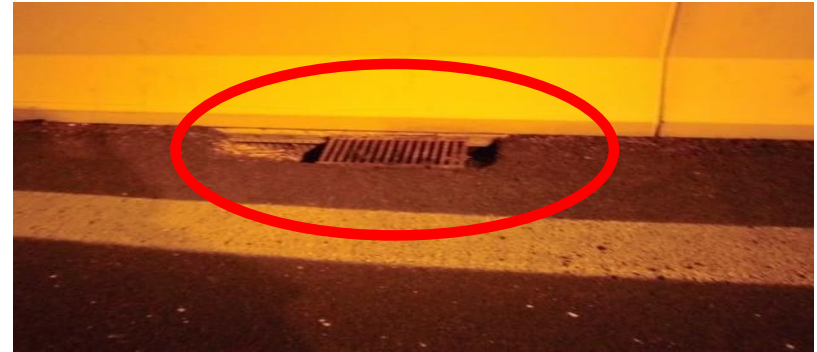
Pozzetti danneggiati e ostruiti
