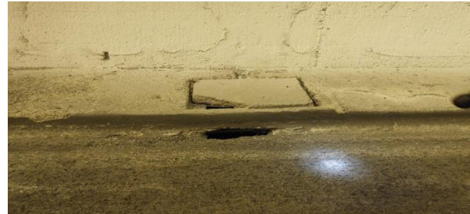
Pozzetti danneggiati e ostruiti
