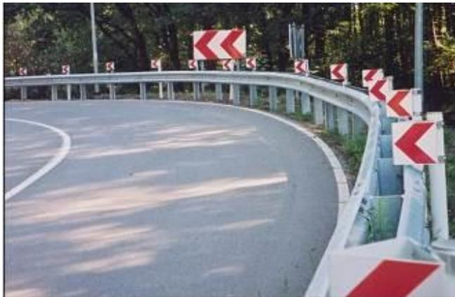
Le barriere esistenti spesso sono fatte di travi di acciaio, montate su paletti di acciaio di sostegno. La causa principale delle lesioni (fatali) ai motociclisti che vengono in contatto con una barriera per gli urti è che il motociclista urta i paletti di sostegno della barriera stessa.
